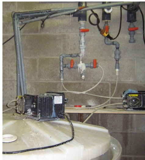
Ex.: Salle de dosage de produits chimiques Risques liés aux vapeurs toxiques
