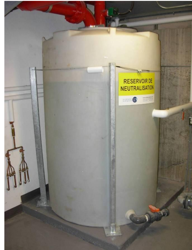
Réservoir de neutralisation en cas de surpression \text{NH}_3 + \text{H}_2\text{O} = \text{NH}_4\text{OH}
