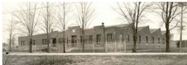
Section d'origine de l'usine Asten Johnson, sur une photographie prise avant 1948. 213, boulevard du Havre, Salaberry-de-Valleyfield. Collection du MUSO
