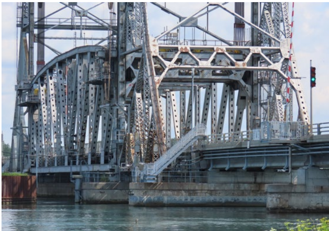
Structure centrale levante, en poutre en treillis avec tablier inférieur, du pont Saint-Louis-de-Gonzague. Le pont, situé entre la municipalité du même nom et Salaberry-de-Valleyfield, surplombe le canal de Beauharnois.
