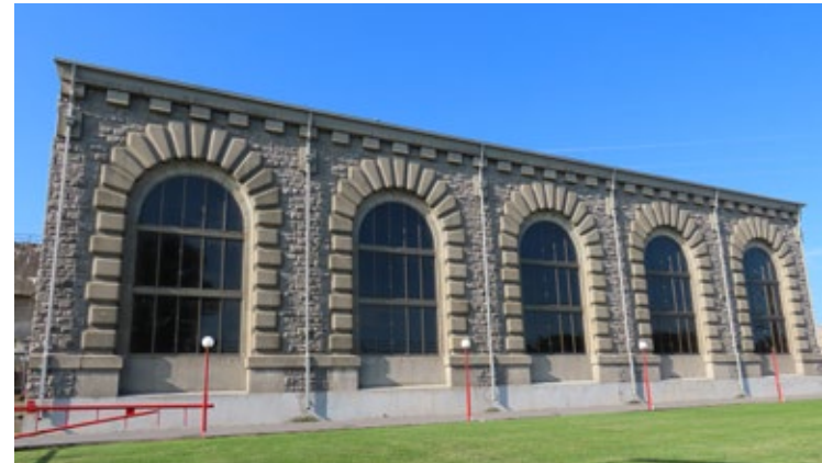
Ancienne centrale hydroélectrique de Saint-Timothée. Un parement en maçonnerie de pierre en bossage recouvre la façade. 5594, boulevard Hébert, Salaberry-de-Valleyfield.
