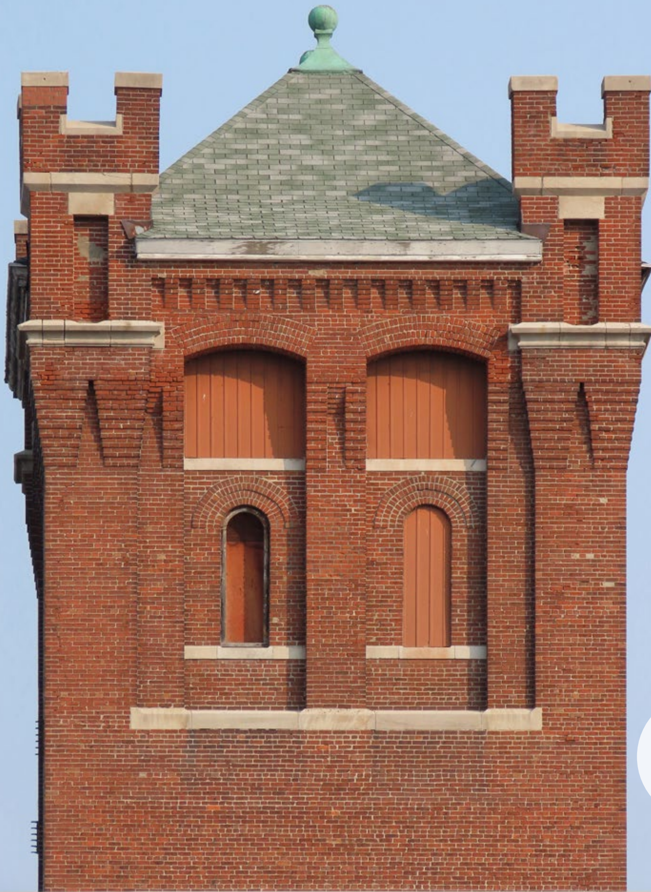
Sommet de la tour de l'ancien moulin Gault, remarquable par ses mâchicoulis d'inspiration médiévale et ses jeux de briques. 40, avenue du Centenaire, Salaberry-de-Valleyfield.
