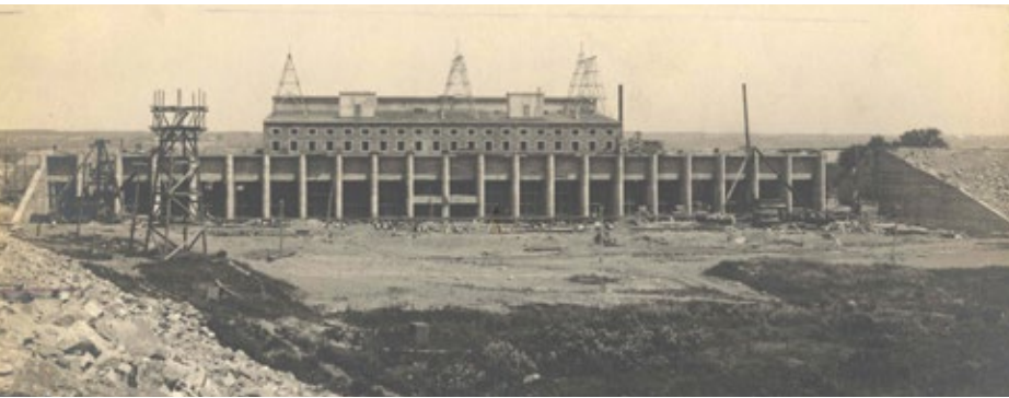
Le barrage de la centrale hydroélectrique de Saint-Timothée, alors en construction, vers 1910-1911. 5594, boulevard Hébert, Salaberry-de-Valleyfield. MUSO, collection Gérald Sullivan
