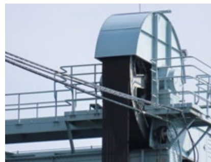
L'une des deux structures permettant de hisser le tablier central du pont Larocque lors du passage des navires.
