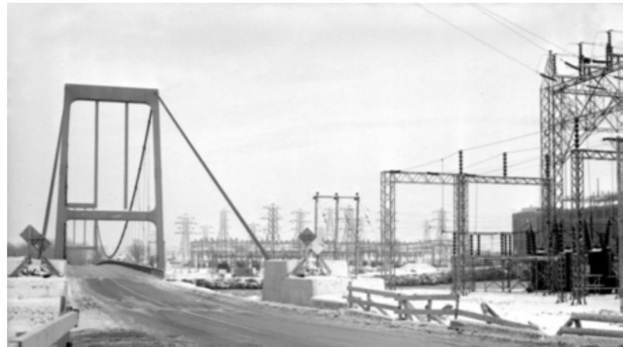
Pont suspendu de Beauharnois. On aperçoit à droite une partie de la centrale hydroélectrique de Beauharnois. Service des ponts. Ministère des Travaux publics. Paul Girard, janvier 1951, BANQ numérique
