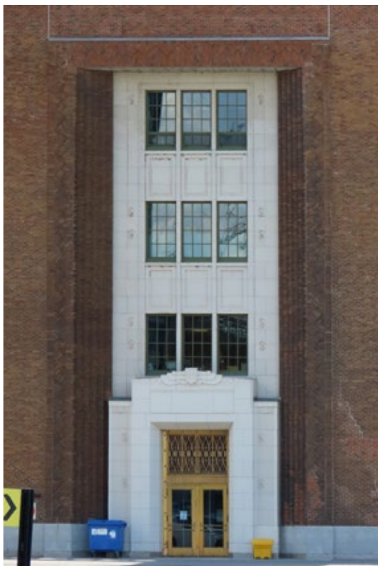
Entrée principale de la centrale hydroélectrique de Beauharnois érigée entre 1929 et 1932. Formes orthogonales, combinaison de la pierre et de la brique, des éléments caractéristiques de l'Art déco. 80, boulevard de Melocheville, Beauharnois.
