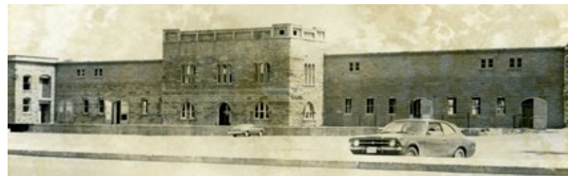
Ancienne centrale électrique de la MOCO, photographiée vers les années 1970. 50, rue Dufferin, Salaberry-de-Valleyfield. Collection du MUSO
