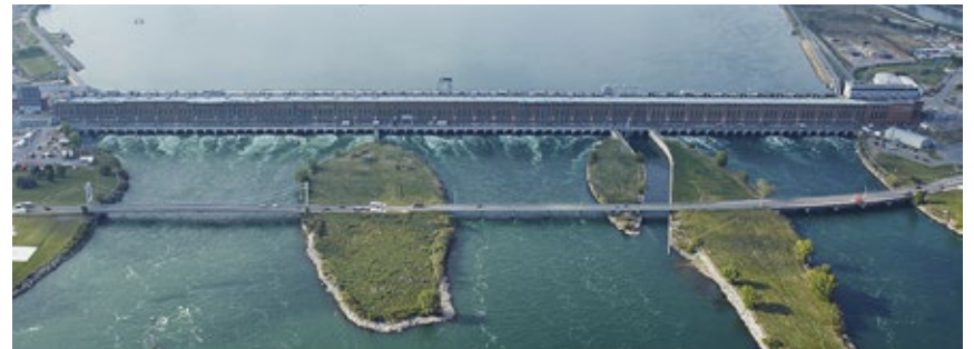
Centrale de Beauharnois, reconnue comme Lieu historique national du Canada. 80, boulevard Melocheville, Beauharnois. Photo : Hydro-Québec ©
