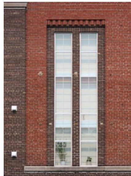
L'influence de l'Art déco est manifeste avec les lignes verticales, les formes orthogonales et les jeux de briques autour des fenêtres. Ancien poste de distribution de la Beauharnois Electric Company datant de 1929. 8, rue Saint-Hippolyte, Salaberry-de-Valleyfield.
