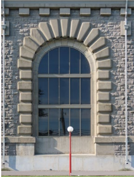
L'une des fenêtres en arc plein cintre singularisant la façade de l'ancienne centrale électrique de Saint-Timothée. 5594, boulevard Hébert, Salaberry-de-Valleyfield.
