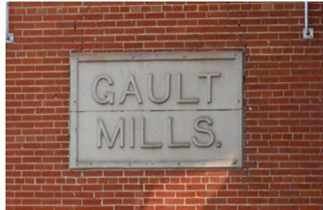
Brique structurale, reconnaissable par les rangées de briques disposées en boutisse, du moulin Gault. 40, avenue du Centenaire, Salaberry-de-Valleyfield.
