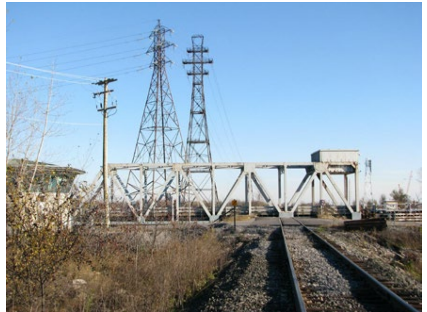
Pont ferroviaire CSX, localisé au-dessus du canal de Beauharnois, juste au nord de l'autoroute 30, dans le secteur Melocheville de Beauharnois. Construit vers 1958, il représente très bien le sous-type de structure en poutre en treillis avec tablier inférieur. Photo : © Struturae.net
