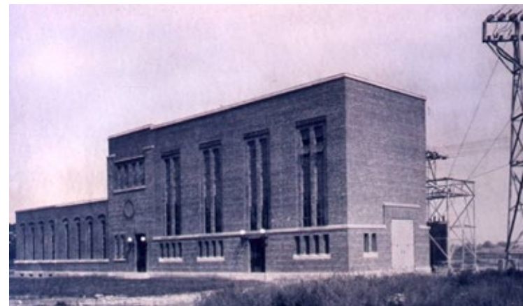
Le poste de distribution de la Beauharnois Electric Company érigé en 1929 et photographié ici vers 1930. 8, rue Saint-Hippolyte, Salaberry-de-Valleyfield. MUSO, collection Jean-Marie Léger
