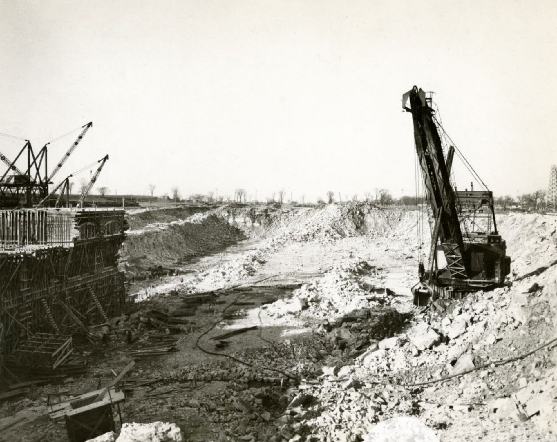
Construction du canal de Beauharnois, vers 1930-1931. Détail d'une photographie de Beauharnois Construction Co., novembre 1930 – janvier 1931. BANQ numérique
