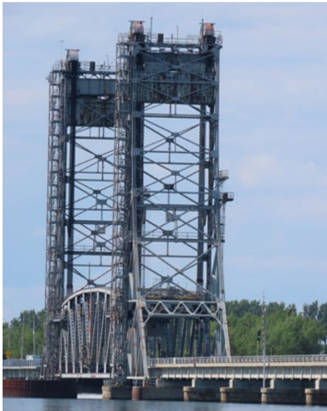
Pont Saint-Louis-de-Gonzague. Le pont, situé entre la municipalité du même nom et Salaberry-de-Valleyfield, surplombe le canal de Beauharnois.
