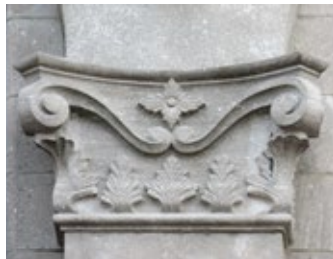
Chapiteau d'inspiration corinthienne, à motifs végétaux, au sommet des pilastres en pierre du 211-215, rue Victoria, Salaberry-de-Valleyfield.
