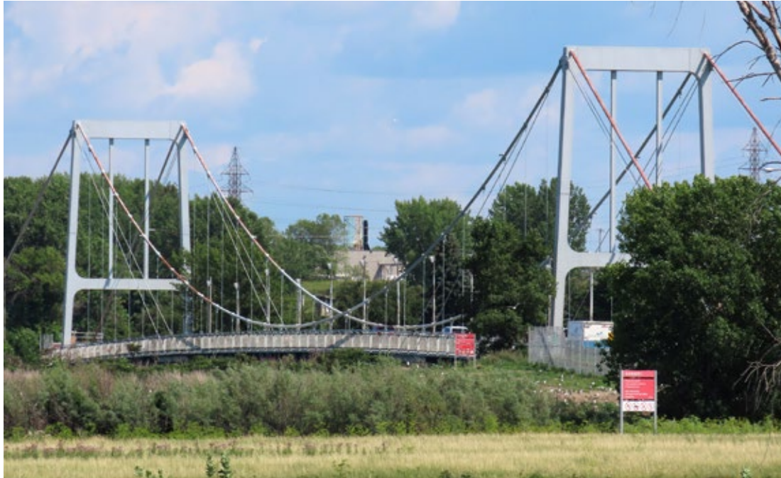
Pont suspendu de Beauharnois construit entre 1951 et 1952. Situé parallèlement à la centrale hydroélectrique de Beauharnois, il permet de traverser le canal du même nom.
