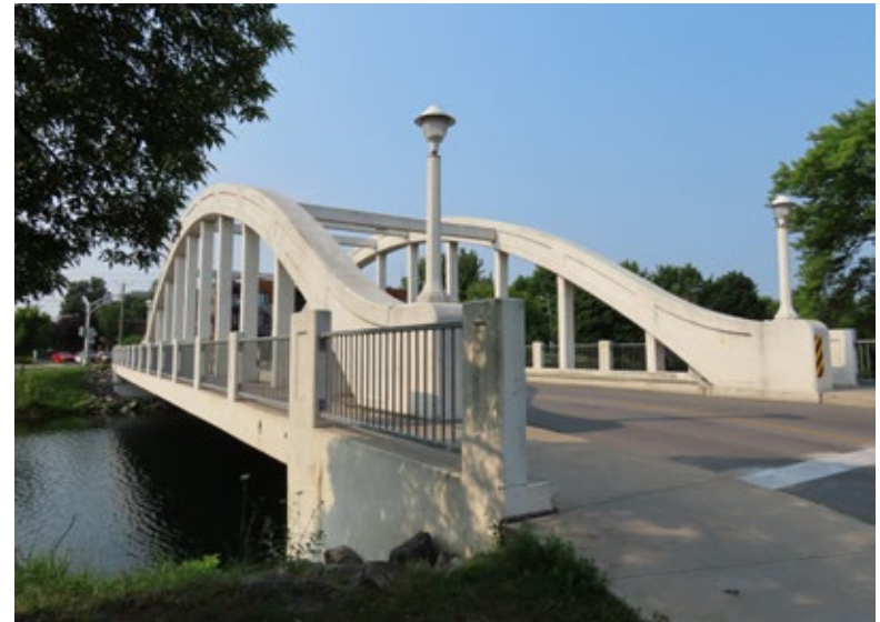
Le pont Salaberry, localisé entre la rue des Érables (au sud) et la rue Saint-Denis (au nord) à Salaberry-de-Valleyfield. Construit en 1932, il enjambe l'ancien canal de Beauharnois.
