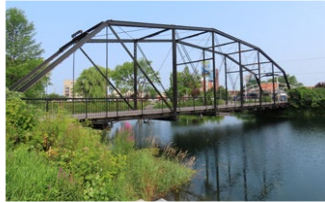
Pont Jean-De La Lande, un bien patrimonial classé, construit entre 1894 et 1895, Salaberry-de-Valleyfield.
