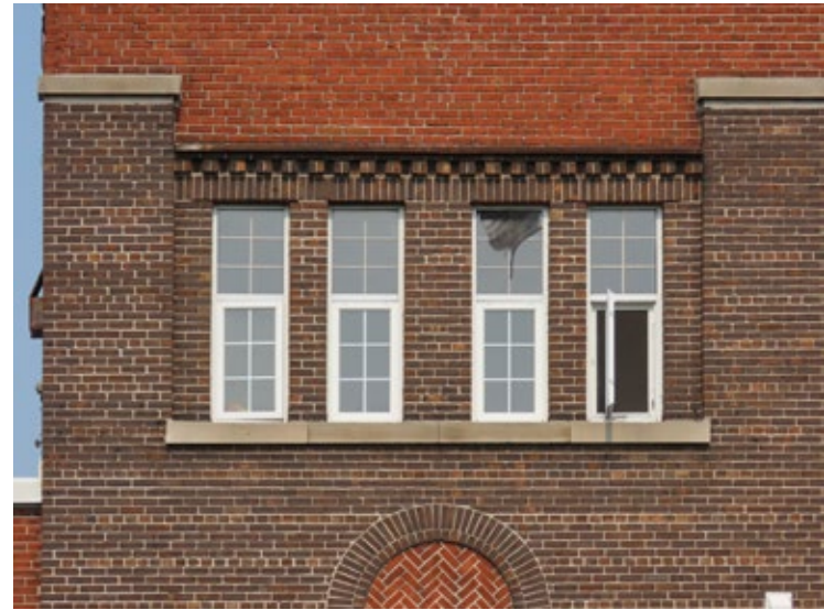
Jeux de briques, typiques de l'Art déco, sur l'ancien poste de distribution électrique de la Beauharnois Electric Company. 8, rue Saint-Hippolyte, Salaberry-de-Valleyfield.
