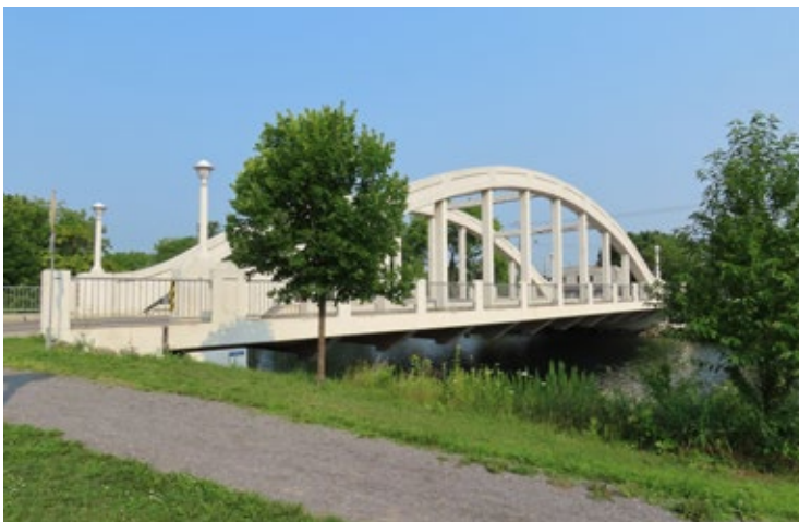
Pont Salaberry, surplombant le premier canal de Beauharnois, Salaberry-de-Valleyfield.
