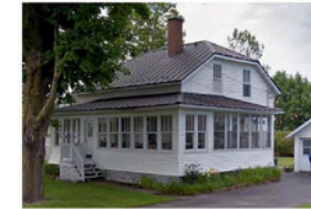
5. Immeuble à toit à demi-croupes
