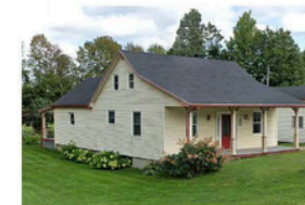
2. Immeuble à toit à double versant droit en façade
