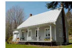
1. Immeuble à toit à deux versants droits
