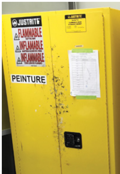
Identification sur l'armoire : « INFLAMMABLE » et « PEINTURE ».
