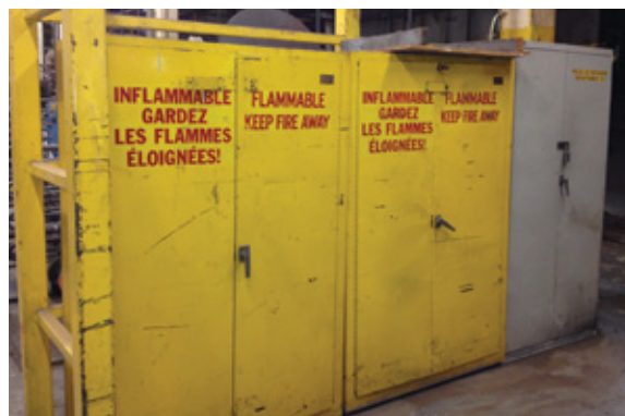
Armoire de sécurité pour produits inflammables
