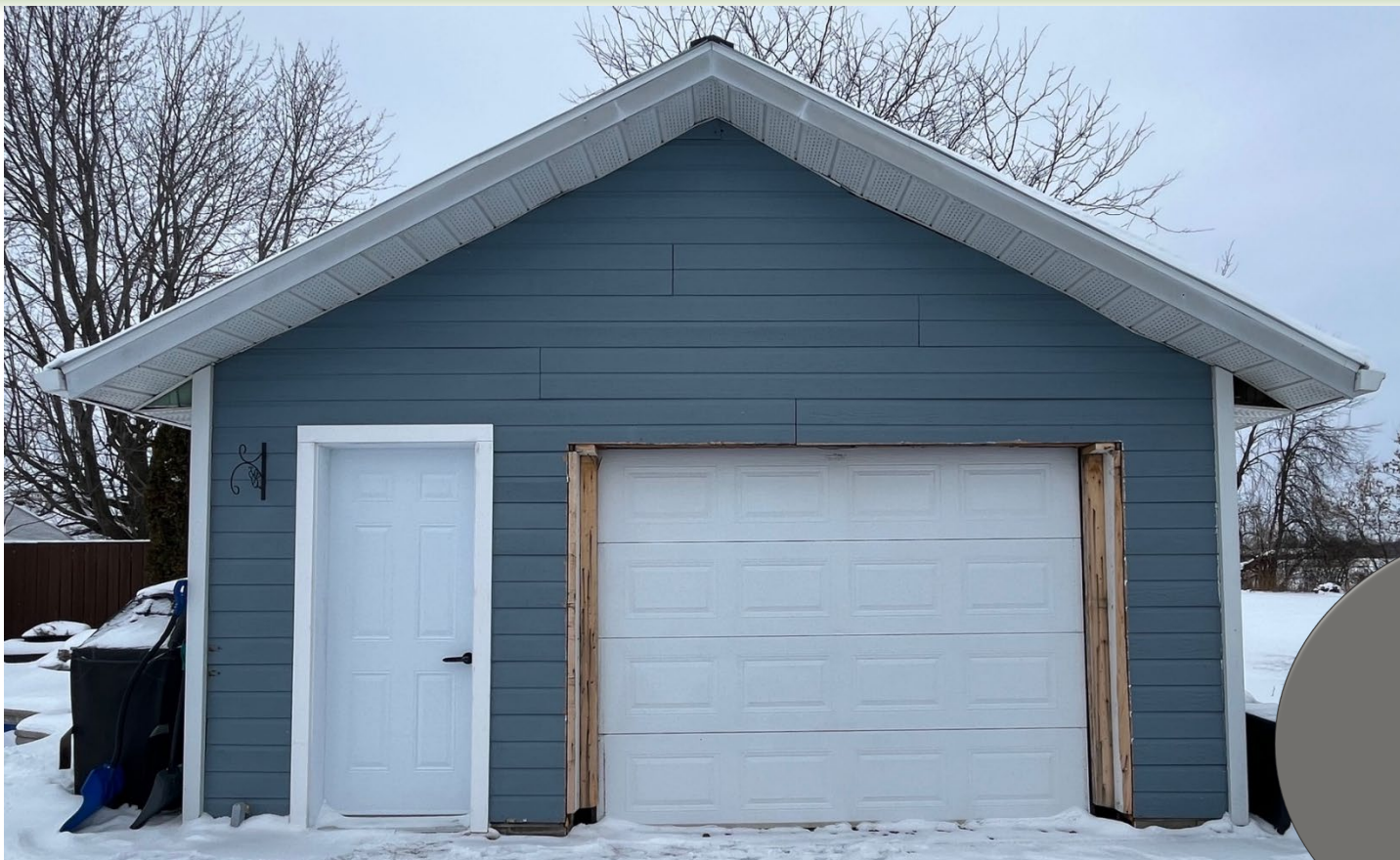
Façade du garage existante
