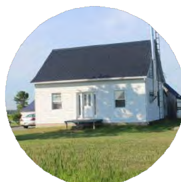
MAISON OUVRIÈRE TOIT AVEC PETIT LARMIER - 1945
