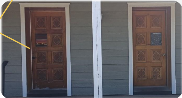
Porte existante à remplacer
