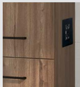
**PRISE GFCI** avec port USB-A et USB-C sur le côté d'une lingerie sans niche
